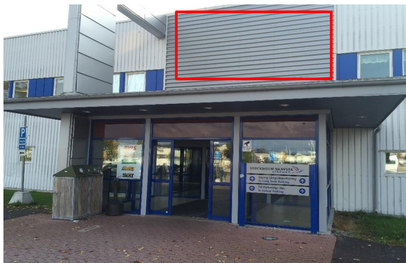
Fasadvepa på parkeringshusentrén mitt emot flygplatsterminalen
